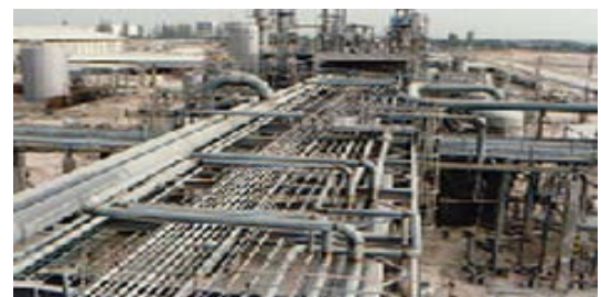
การติดตั้งระบบท่อ อุตสาหกรรมปิโตรเคมี
